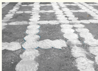
改良した地盤の状況
