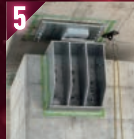
ボルト仮締結・本締結
