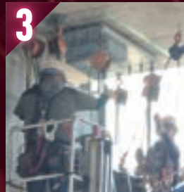
人力作業で 設置高まで揚重
