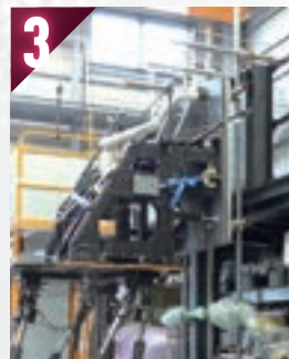
ロボットアームを用いて ボルト仮締結
