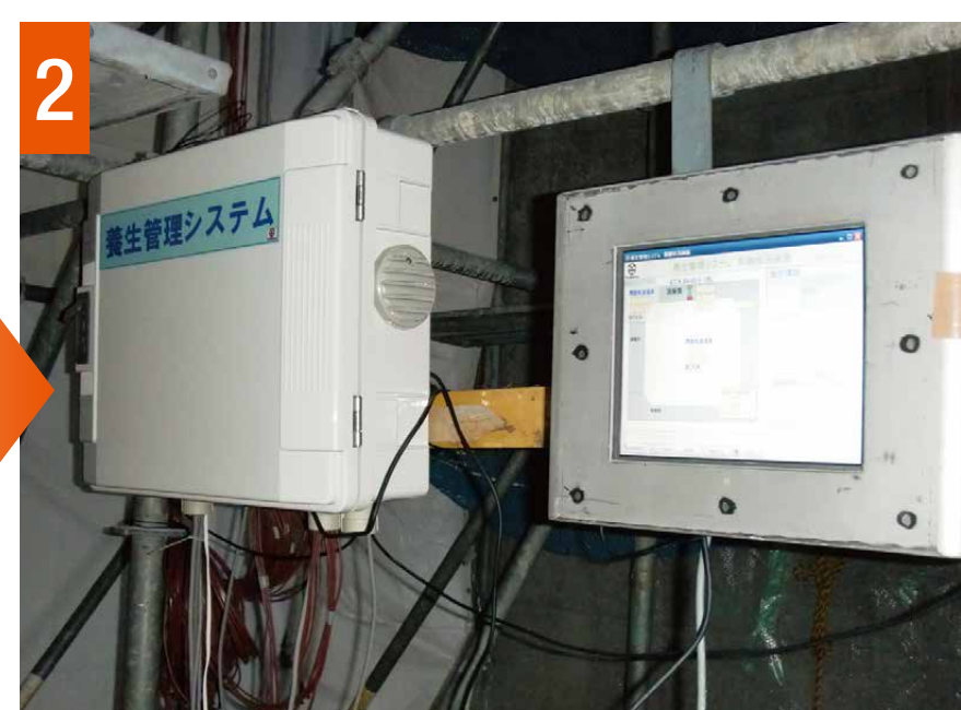
2 現場の外気温やコンクリート温度をモニタリングします。
