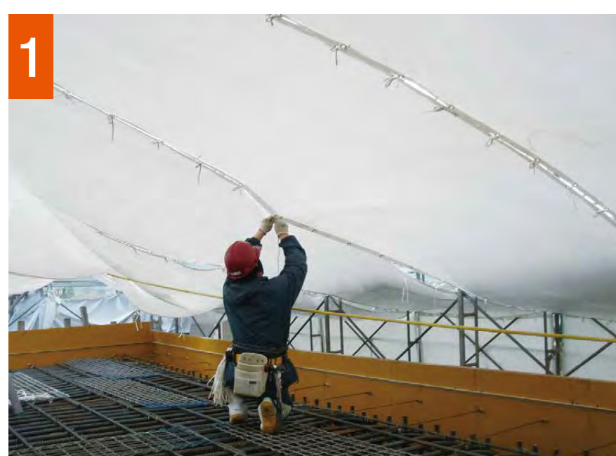
1 構造物をシートで囲い、養生空間を作り、コンクリートを打設します。
