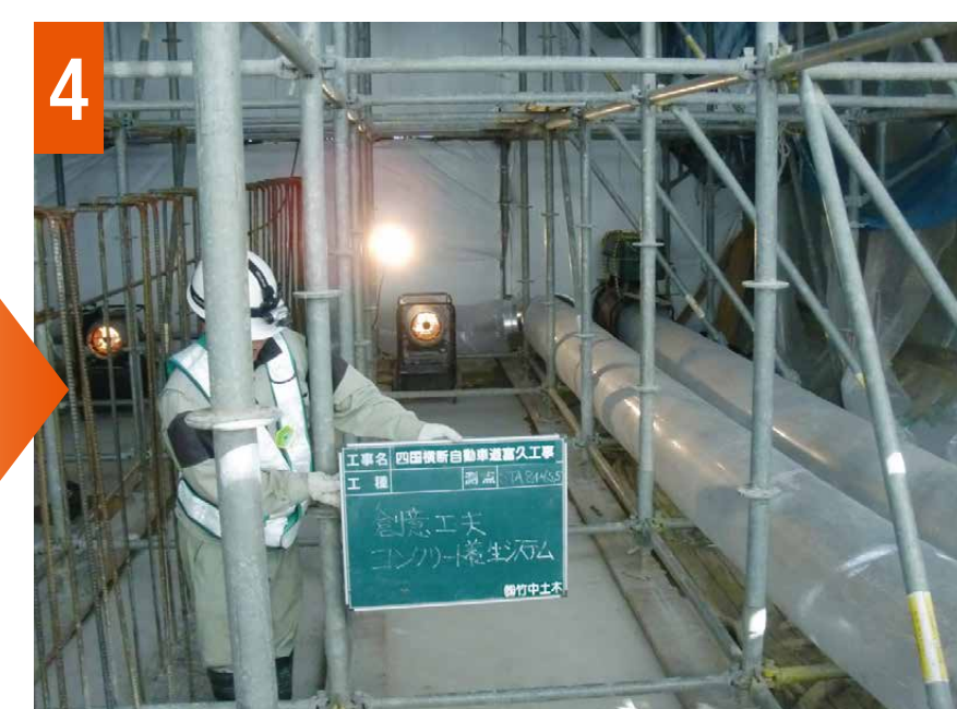
4 養生空間の温度、湿度、気流を自動制御します。
