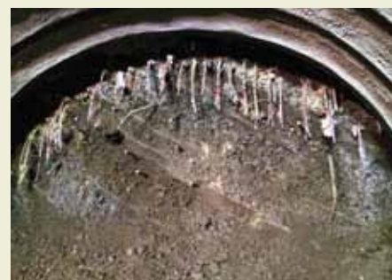
盛土区間の切羽状況
