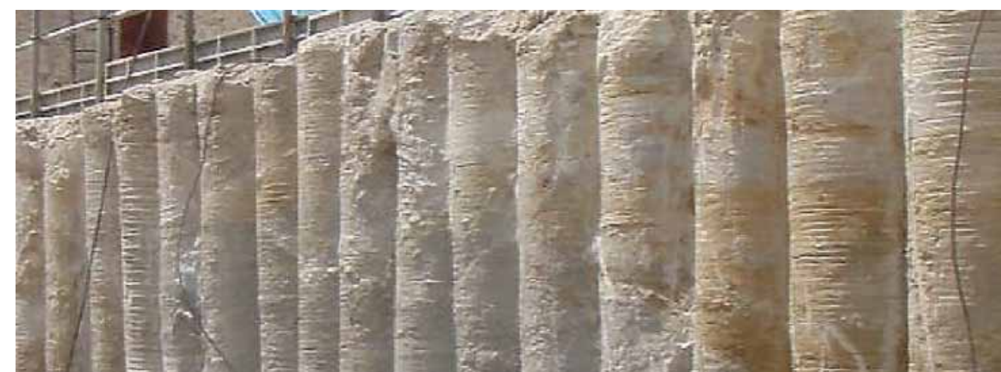
DCM-L 地盤改良体による柱列壁
