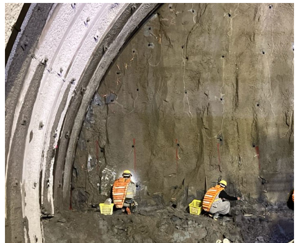
図 1 従来の爆薬装填状況イメージ
