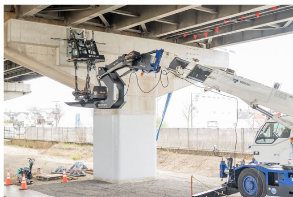
図4 耐震補強部材取付ロボット 試験施工状況
