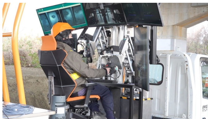
図5 耐震補強部材取付ロボット 操作状況
