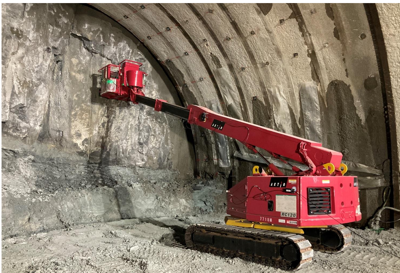
写真-2 現場での遠隔岩判定実証実験状況写真
