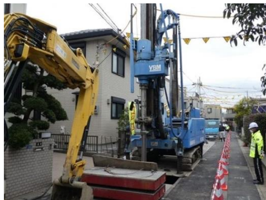
写真 2 スマートコラム工法による施工状況
