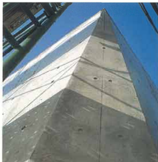
面取り部の充填状況/Filling at the Corner
