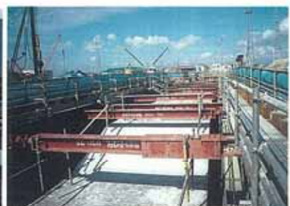
海水排水路 コンクリート打設工事
