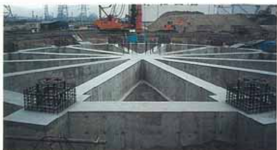
球形ガスホルダー基礎工事
