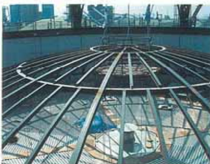
屋根リフトアップ工事
