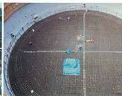
底版鉄筋工事
