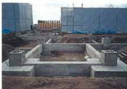
配管ラック基礎工事
