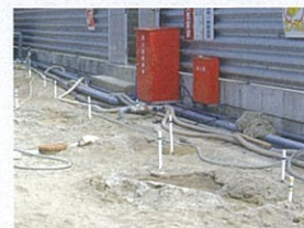
注入管設置状況
