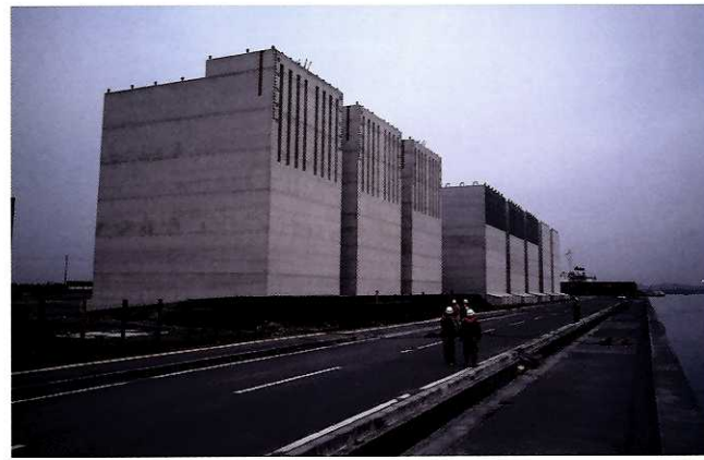
ケーソン完成状況
