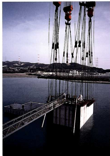
ケーソン据付状況
