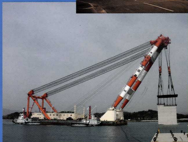
ケーソン据付状況 耐震函据付
