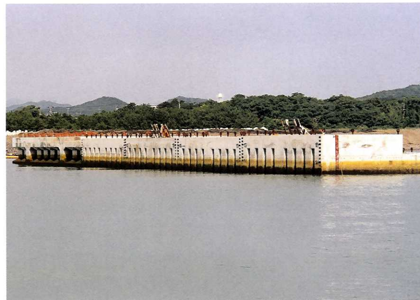
据付完了状況
