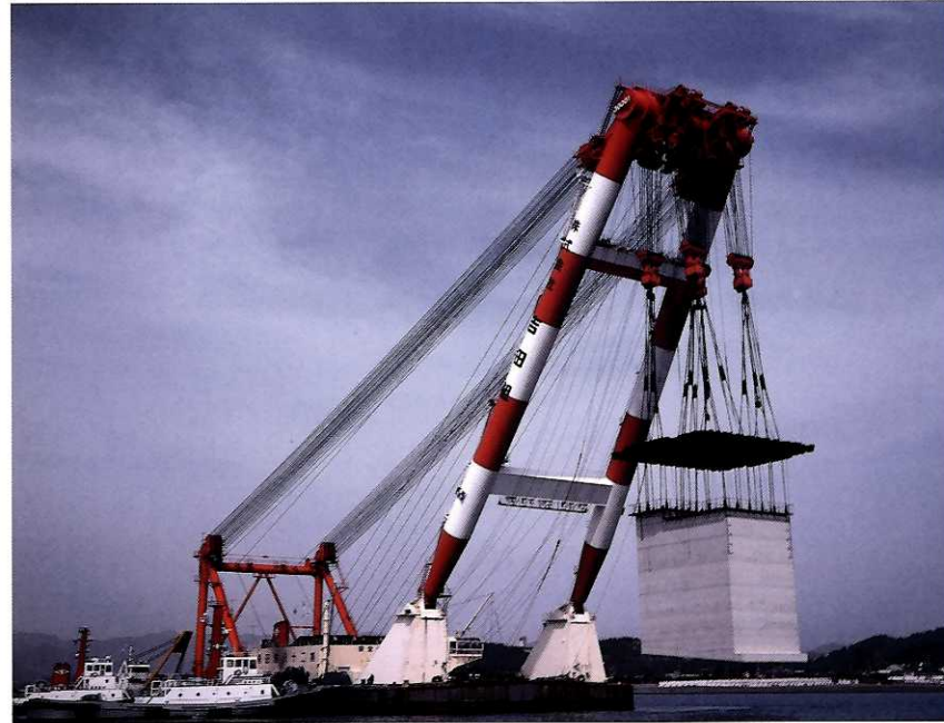
ケーソン曳航状況
