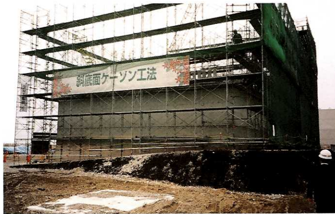
ケーソン製作状況
