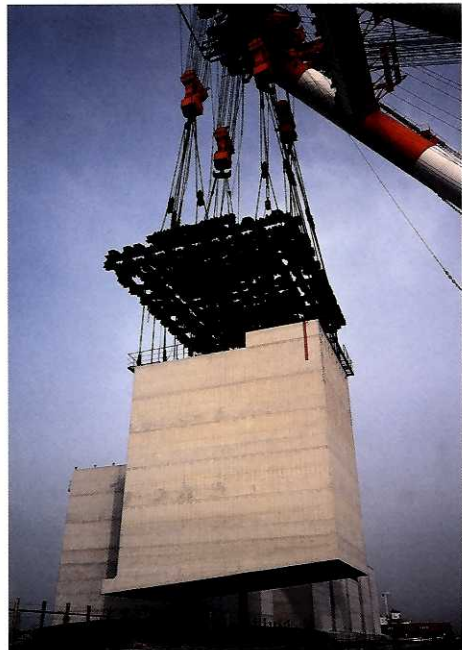
ケーソン吊出状況
