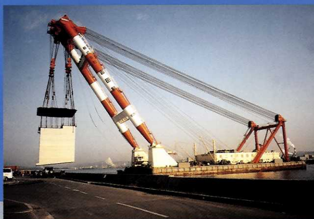
ケーソン吊出状況
