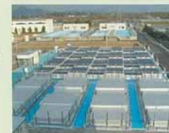
滋賀県企業庁 吉川浄水場(滋賀県)
