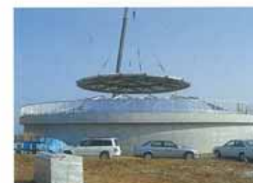
クレーン上架(ドーム)
