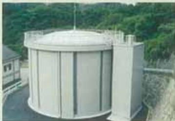
神戸市水道局 新鳥原調整池 (兵庫県)
