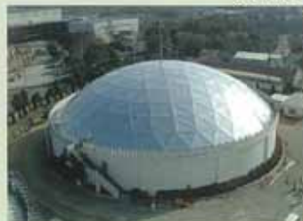
明石市 中部配水場2号PCタンク (兵庫県)
