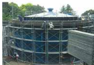
鋼製屋根解体
