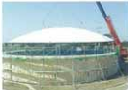
タンク外でのドーム組立・上架
