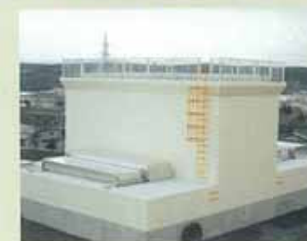
八戸圏域水道企業団 白山浄水場(青森県)
