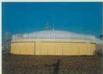
銚子市 上野町配水場1号配水池 (千葉県)
