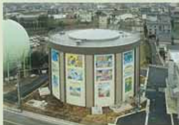
習志野市 水道第2給水場 (千葉県)
