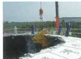
特殊ニプラによるドーム解体
