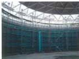
タンク内でのドーム組立・上架
