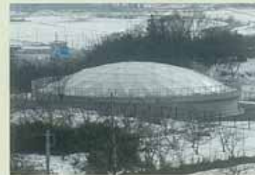
桑折町 平沢中区配水池 (福島県)
