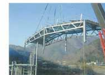
クレーン架設(覆蓋)
