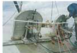
ウォールソーによるドーム解体
