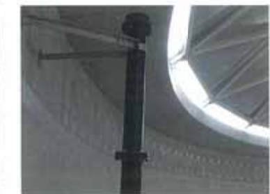
写真は端部パネル施工前
