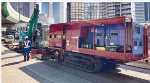
IH式舗装撤去工法
