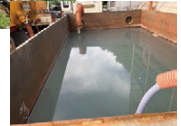
簡易濁水処理設備
