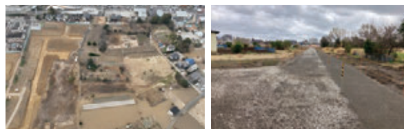
歩道整備着工前
