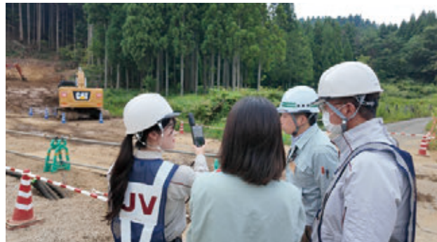
トンネル工事の完成形を最新のICT機器を用いて説明するi-Con研修生
