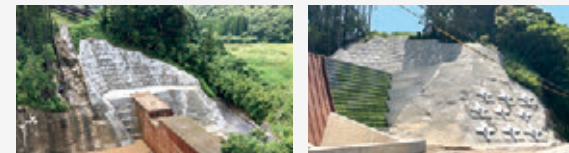
宮崎県串間市 災害復旧工事
