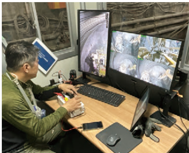
切羽から150mほど離れた遠隔操作室で安全に作業を実施
