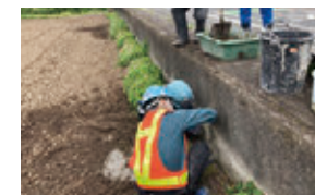
側溝クラックの補修
