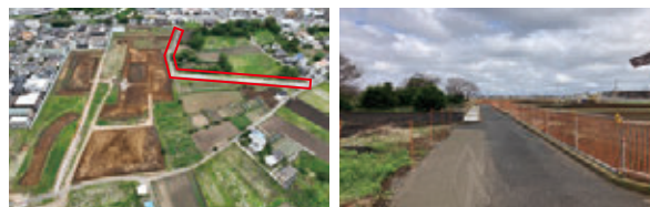
歩道整備完了後
