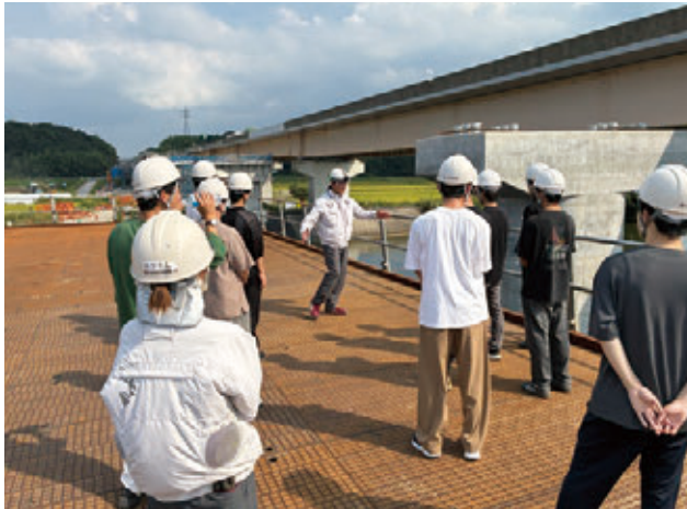
2025年度インターンシップ(高速道路橋梁の下部工工事)
