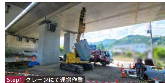
Step1 クレーンにて運搬作業
