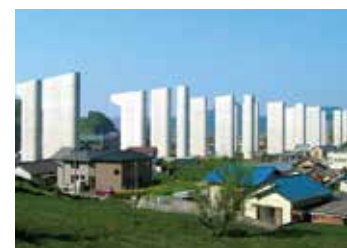
第二東名静岡IC橋 2005年/静岡県
