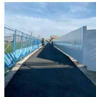
整備された仮設歩道
