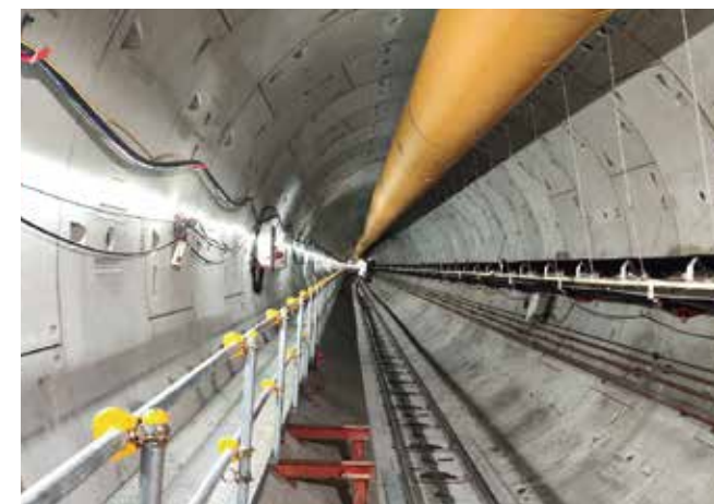
施工が進むシールドトンネル
