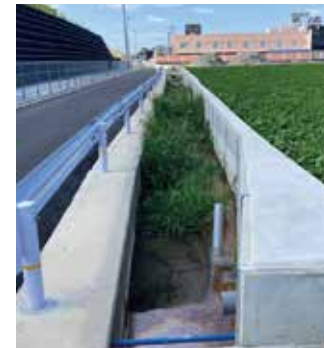
しゅん渫前の水路
