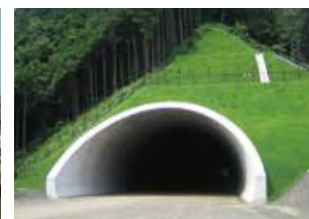
第二東名清水第二トンネル 2010年/静岡県
