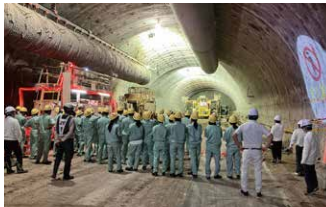
地域との交流を深めるトンネル工事見学会
