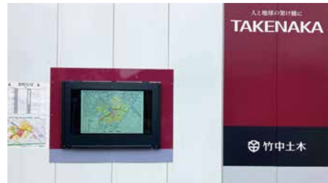
工事用仮囲いに設置されたデジタルサイネージ
