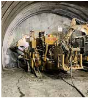
切羽の自由断面掘削機
