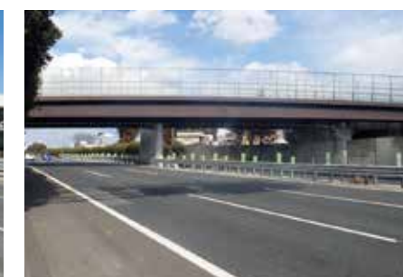
東北道仁良塚橋耐震補強 2022年/栃木県
