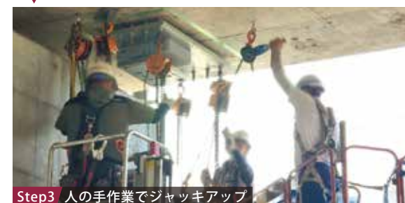
Step3 人の手作業でジャッキアップ
