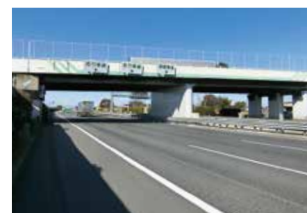
東北道六万部橋耐震補強 2022年/埼玉県
