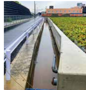
水路しゅん渫完了
