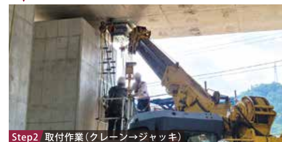
Step2 取付作業(クレーン→ジャッキ)
