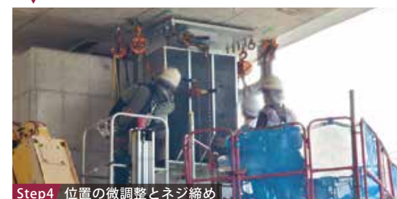
Step4 位置の微調整とネジ締め
