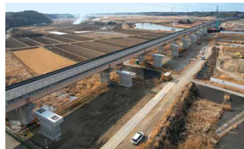
圏央道江戸崎橋(下部工) 2025年完成予定/茨城県
