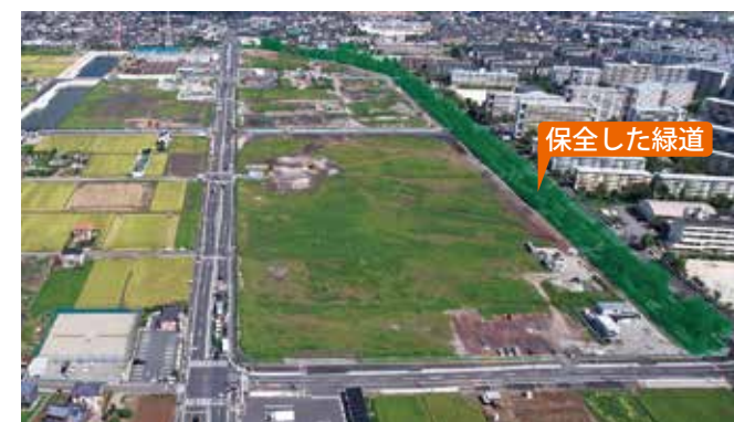
現場前景および保全した緑道
