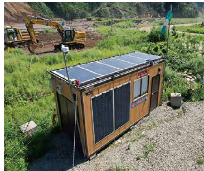
現場に設けた「クリーンエネ・ハウス」
