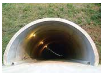
第二東名金谷トンネル西 2003年/静岡県
