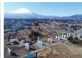
新東名ぐみ沢上高架橋(下部工) 2019年/静岡県
