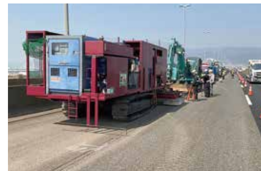
IH式舗装撤去(阪神高速道路・湾岸線)
