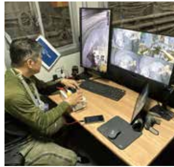
遠隔操作システムによる掘削作業
