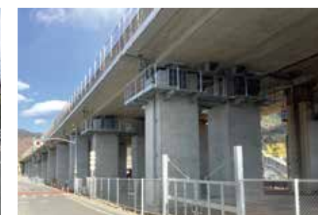
中央道大月～都留IC耐震補強 2025年完成予定/山梨県
