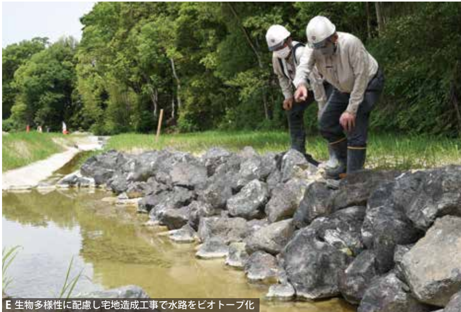
E 生物多様性に配慮し宅地造成工事で水路をビオトープ化
