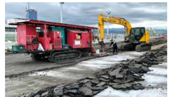
IH式舗装撤去(阪神高速道路・中島PA)
