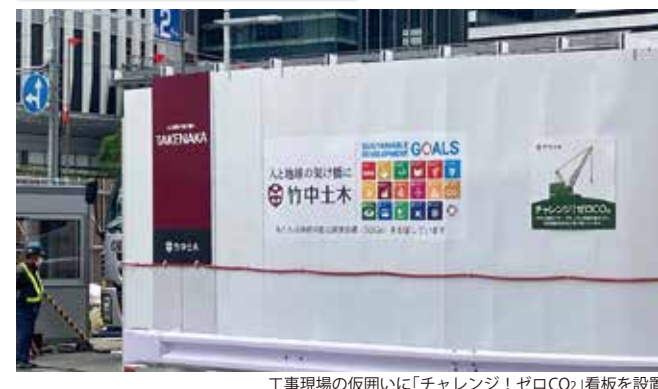
工事現場の仮囲いに「チャレンジ！ゼロCO 2 」看板を設置
