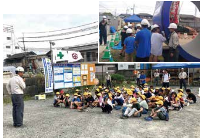
小学生の工事見学会で推進管に寄せ書き
