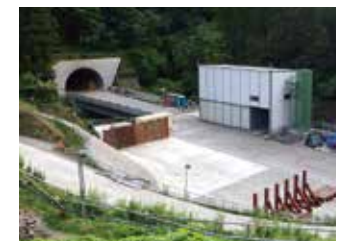
坑口周辺のコンクリート舗装
