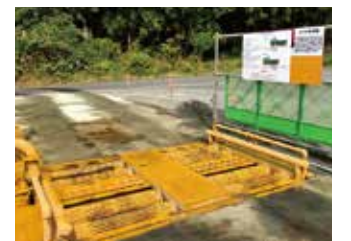
工事用車輛のタイヤ洗浄機
