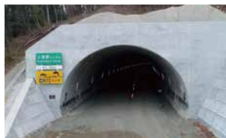
東北中央自動車道 上保原トンネル(福島県)
