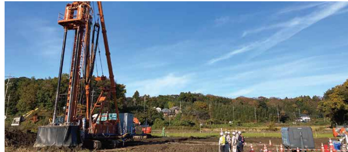
3点式施工機による高速道路盛土区間の地盤改良(茨城県)
