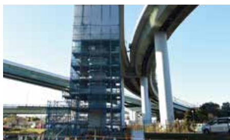
東名横浜青葉インターチェンジ耐震補強 (神奈川県)
