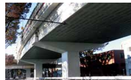
首都高速道路 (永福) 上部工補強 (東京都)
