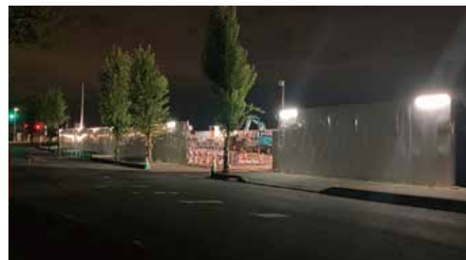
工所用仮囲いに設置されたLED照明
