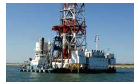
DCM船による海底の地盤改良(東京都)
