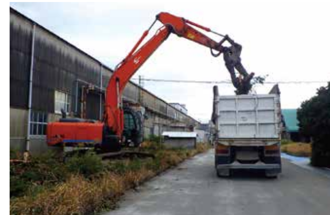
伐採材をバイオマス発電の燃料として再資源化
