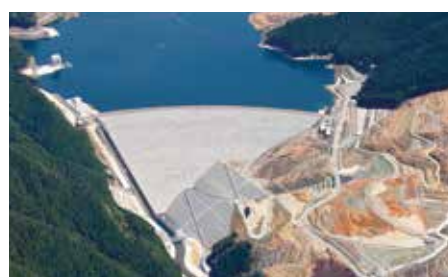
小石原川ダム(福岡県)
