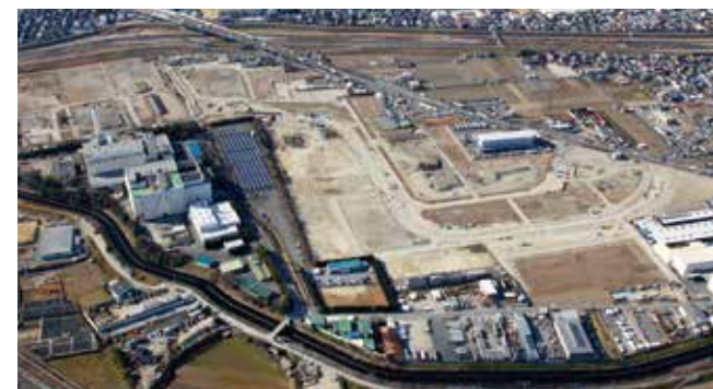
茨木市南目垣・東野々宮地区土地区画整理事業の全景
