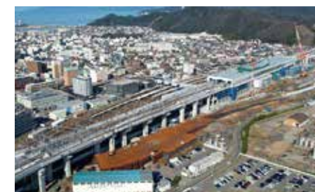
北陸新幹線 敦賀駅高架橋(福井県)
