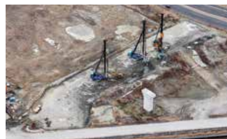
DCM-L工法による臨港道路の地盤改良(三重県)
