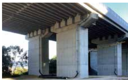
常盤高架橋他3橋 耐震補強 (香川県)
