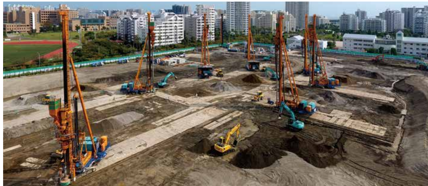
大規模複合用地における地盤の液状化対策(千葉県)
