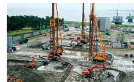
高速道路盛土工事における地盤改良(徳島県)
