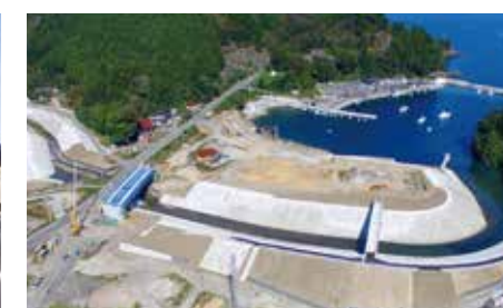
青野沢川河川堤防整備(宮城県)
