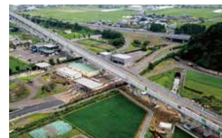
北陸新幹線 武生橋りょう(福井県)
