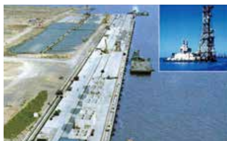
DCM工法による天津港海底地盤改良(中国)
