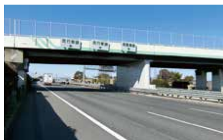
東北道六万部橋他 跨高速道路橋耐震補強 (埼玉県)
