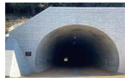
国道161号小松拡幅北小松トンネル(滋賀県)
