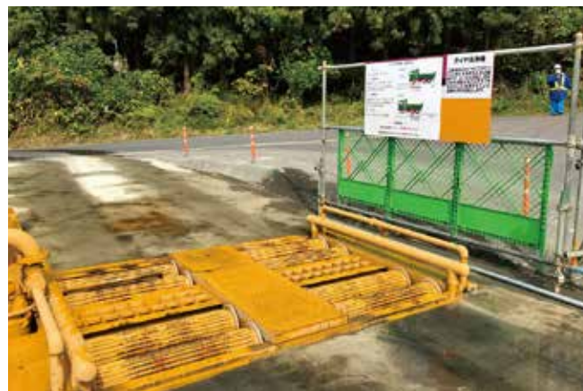
工事車両のタイヤ洗浄装置を設置
