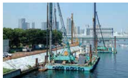
DCM工法による河川の地盤改良(東京都)
