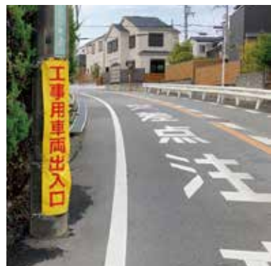
「注意喚起」の標識を設置
