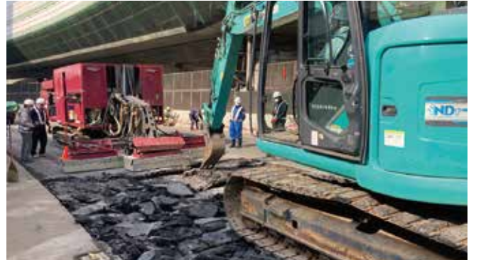
IH式舗装撤去(阪神高速道路)
