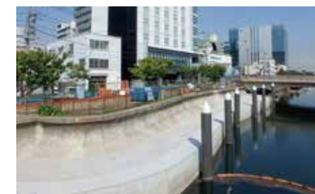
海老取川防潮堤耐震補強 (東京都)
