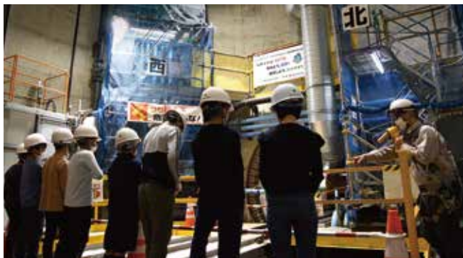
シールドトンネル工事の現場見学
