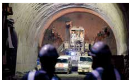
北海道新幹線 立岩トンネル「ルコツ」(北海道)
