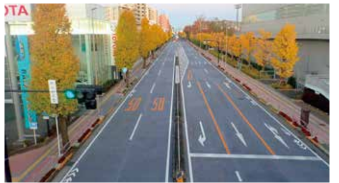
遮熱性舗装(江東区)
