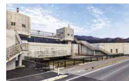
大船渡港跡浜地区海岸防潮堤(岩手県)
