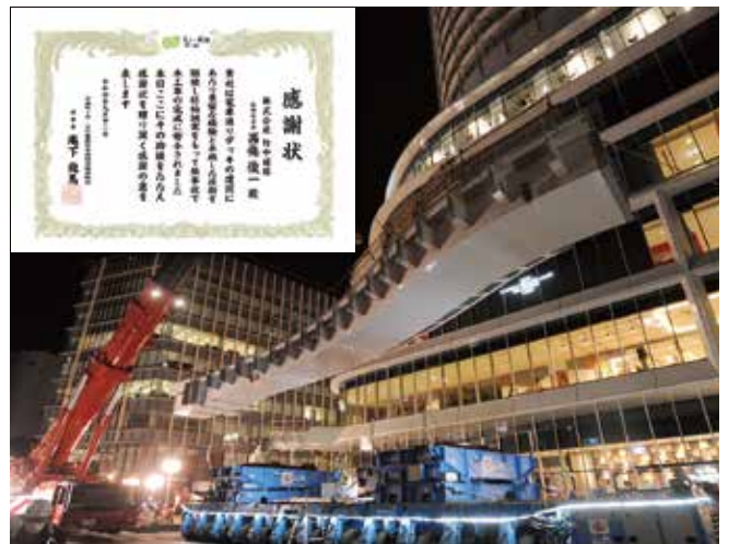
「ベデストリアンデッキ」懸架の様子
