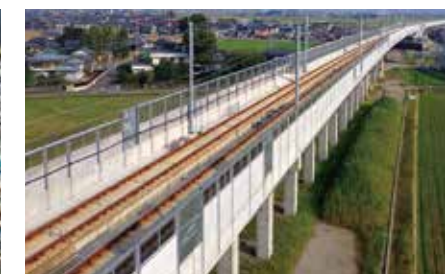
北陸新幹線 丸岡春江高架橋(福井県)
