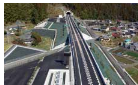
中部横断自動車道 東根熊トンネル(山梨県)
