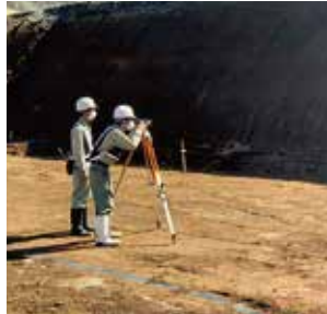
インターンシップ(高速道路IC作業所)
