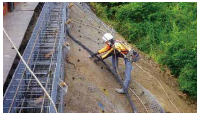
市道崩落法面の復旧作業
