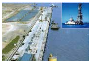
天津港海底地盤改良(中国)
