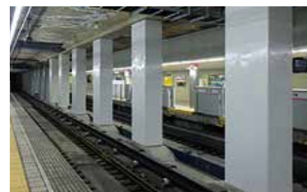
大阪地下鉄2・5号線耐震補強 (大阪府)
