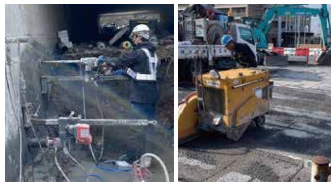
騒音・振動の発生を抑制する施工法を提案・実施
