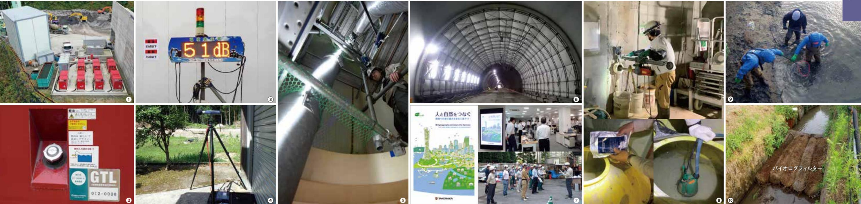
①②：脱炭素に貢献する軽油代替燃料を現場に導入 ③④：騒音・振動をモニタリングして周辺環境に配慮 ⑤⑥：LED照明を現場に導入して電力使用量を抑制
