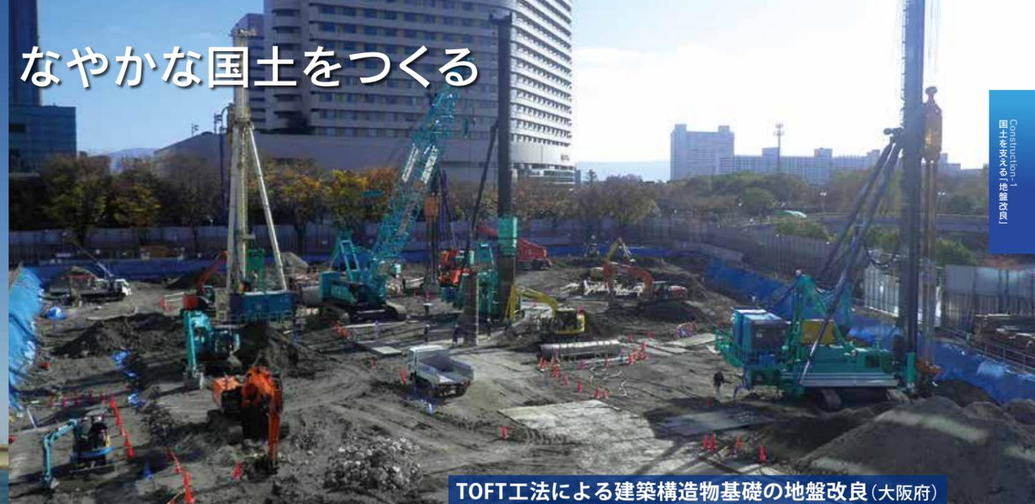
TOFT工法による建築構造物基礎の地盤改良(大阪府)
