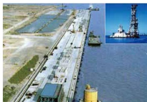
DCM工法による天津コンテナバース地盤改良(中国)
