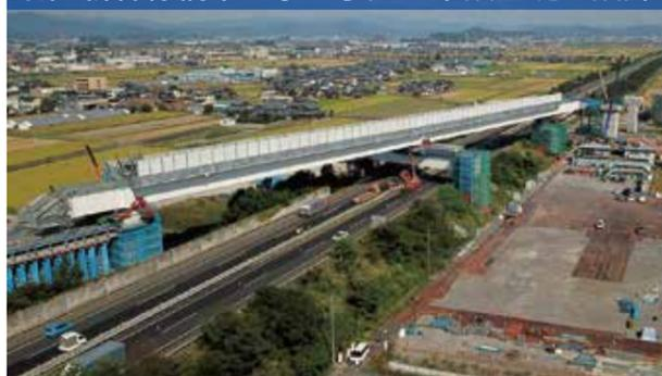
現場に寄り添った技術支援で最良の解決策を…技術支援で印象に残っているのが、鋼重量2,800tの鋼製桁を手延べ架設する「架台の設計」を担当した北陸新幹線の橋梁工事。既設の北陸自動車道を跨ぐ上部工は非常に重構造ゆえ、一般の仮設橋台の3倍相当の荷重に耐える構造設計を行ったのですが…施工中は常に「大丈夫かな?」…心配が高じて架台が壊れる夢をみることも度々。無事に施工が終わった時には充実感よりも「ホッとした」が本音…「不安からの解放」が何より嬉しかったですね。施工がうまく進み「無事に工事を完了する」ことこそが技術支援のやりがい…これからも現場に寄り添って方策を
