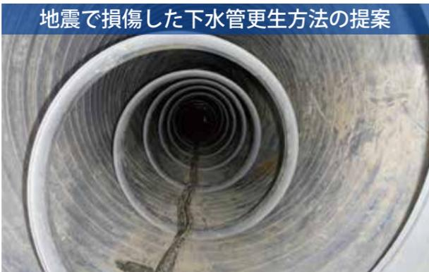
持続可能な社会に向けて技術面で貢献を…大阪北部の分流汚水を集水している幹線において一部管渠の腐食が確認され、自治体が補修計画を進めていた中で大阪北部地震により下水管渠が損傷し道路陥没が発生。道路通行規制は夜間のみ、道路下にインフラ埋設管が密集、二次災害発生リスク等…複雑な施工条件に対処すべく「高圧噴射攪拌工法を実施後に管更正を行う施工方法」を計画・提案。確実な止水対策と逸泥の防止、管内掘削時の施工性確保や地下埋設物への影響等に気を配りながら施工を行い、施工条件や作業環境が非常に悪い中での難工事でしたが、二次災害の発生なく完了しました。
