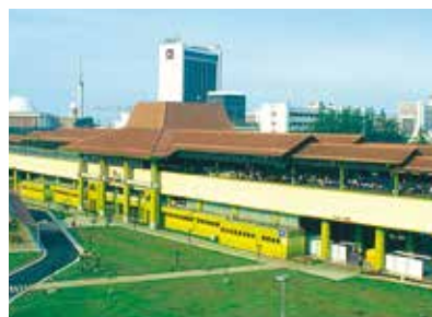
ジャカルタ中央駅舎(インドネシア)
