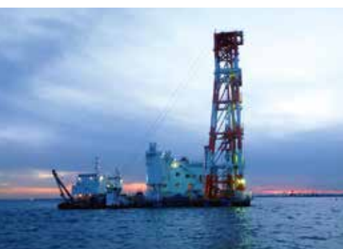
DCM船による海底の地盤改良(東京都)
