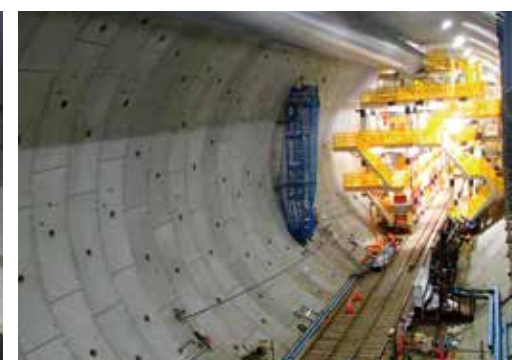
東京外環本線シールドトンネル 大泉南(東京都)
