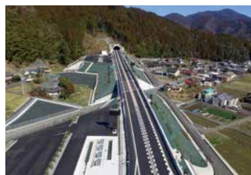
中部横断自動車道 東根熊トンネル(山梨県)
