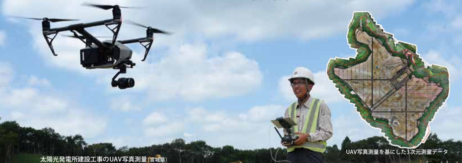
太陽光発電所建設工事のUAV写真測量(宮城県)
