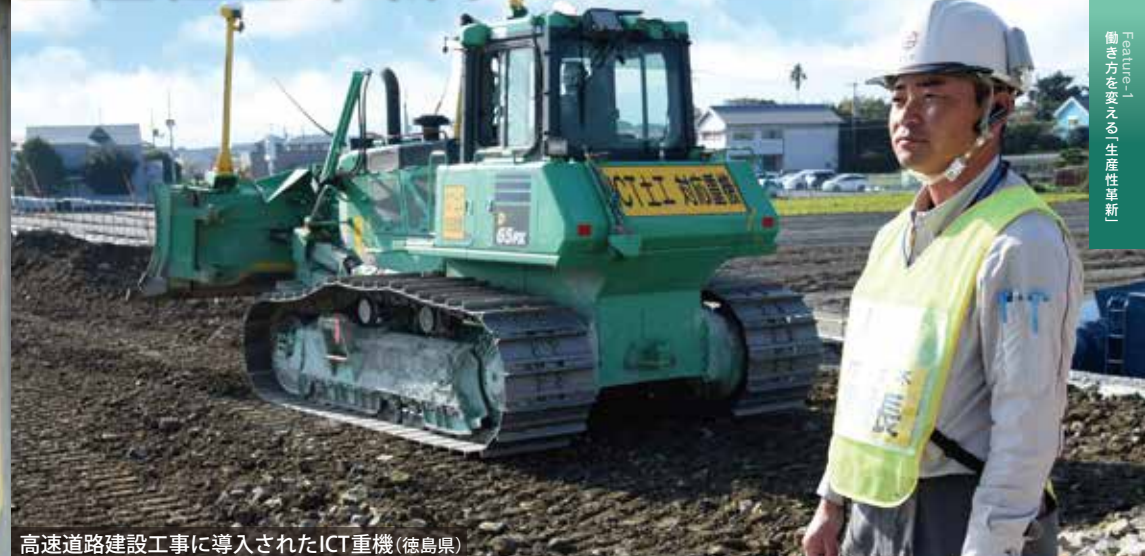
高速道路建設工事に導入されたICT重機(徳島県)
