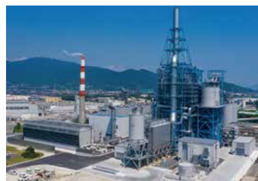
防府バイオマス・石炭混焼発電所（山口県）
