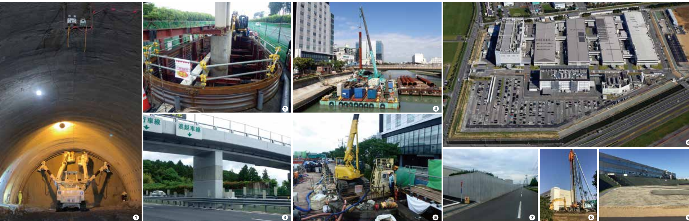
①：「切羽挙動監視システム」の現場運用(福島県) ②③：跨高速道路橋の耐震補強工事(栃木県) ④⑤：大規模地震に備える防潮堤の地盤改良＆機能強化(東京都)
