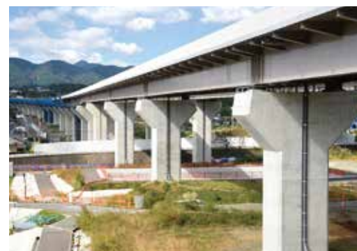
新東名高速道路 葛葉川橋下部工(神奈川県)
