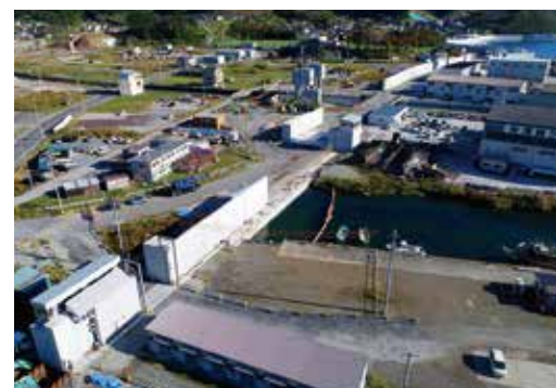
大船渡港跡浜地区海岸防潮堤(岩手県)
