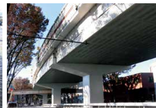
首都高速道路(永福)上部工補強(東京都)
