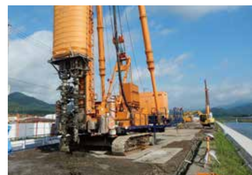
河川堤防復旧工事における地盤改良(岩手県)
