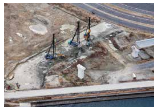
DCM-L工法による港湾法に基づく臨港道路の地盤改良(三重県)
