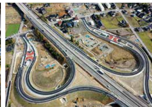
北陸自動車道 上市スマートインターチェンジ(富山)
