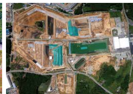
大熊町除染土壌等中間貯蔵施設（福島県）
