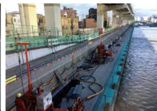
綾瀬川護岸耐震補強(東京都)
