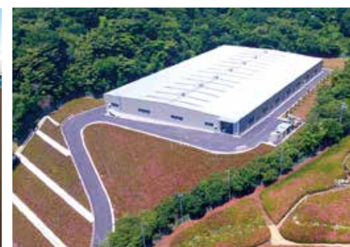
湯河原町真鶴町一般廃棄物最終処分場（神奈川県）
