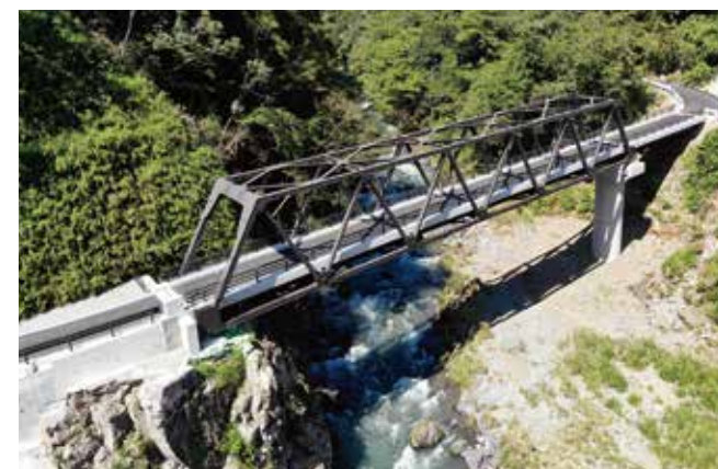
緑豊かな周辺環境に溶け込む橋梁
