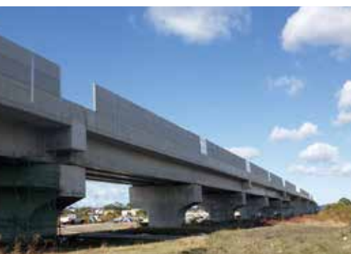
北陸新幹線 丸岡春江高架橋(福井県)
