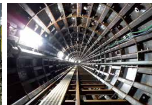
都市ガス用シールドトンネル(茨城県)
