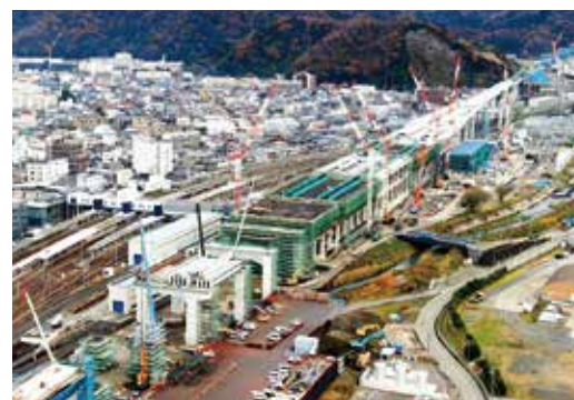
北陸新幹線 敦賀駅高架橋(福井県)
