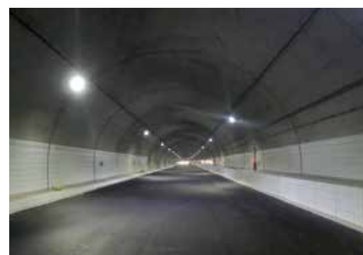
中部横断自動車道 城山トンネル(山梨県)
