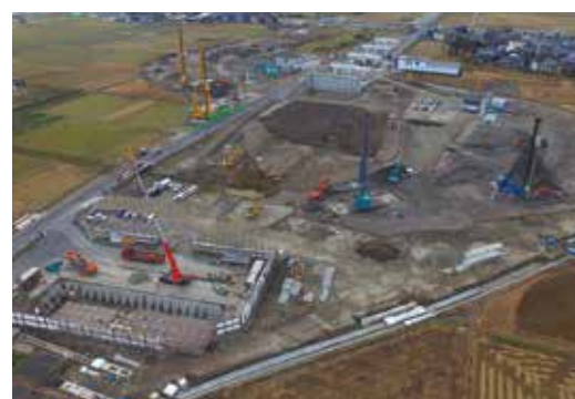
高速道路高架橋工事における地盤改良(岐阜県)
