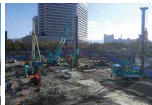
TOFT工法による建築構造物基礎の地盤改良(大阪府)
