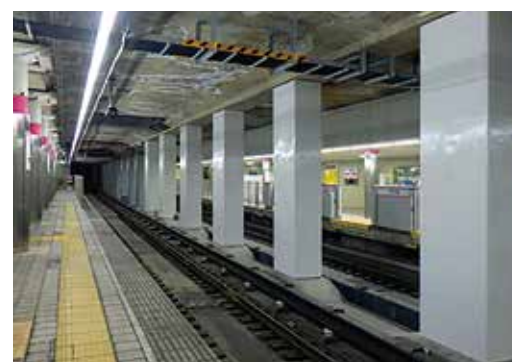
大阪地下鉄2・5号線耐震補強(大阪府)
