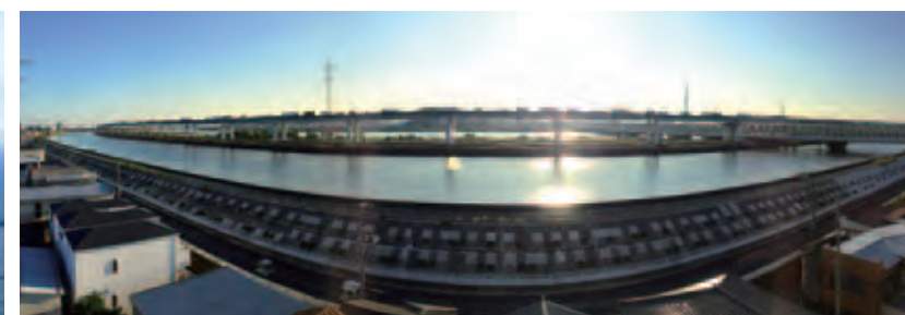
中川防潮堤耐震補強(東京都)
