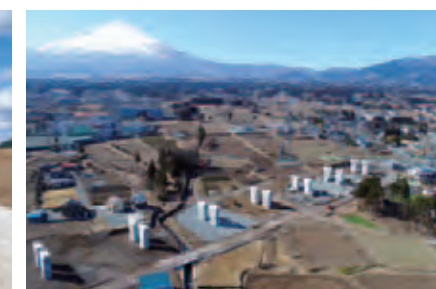
新東名くみ沢上高架橋(静岡県)
