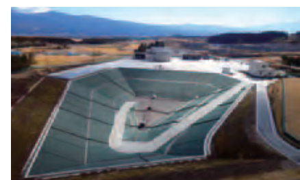
裾野市廃棄物最終処分場
