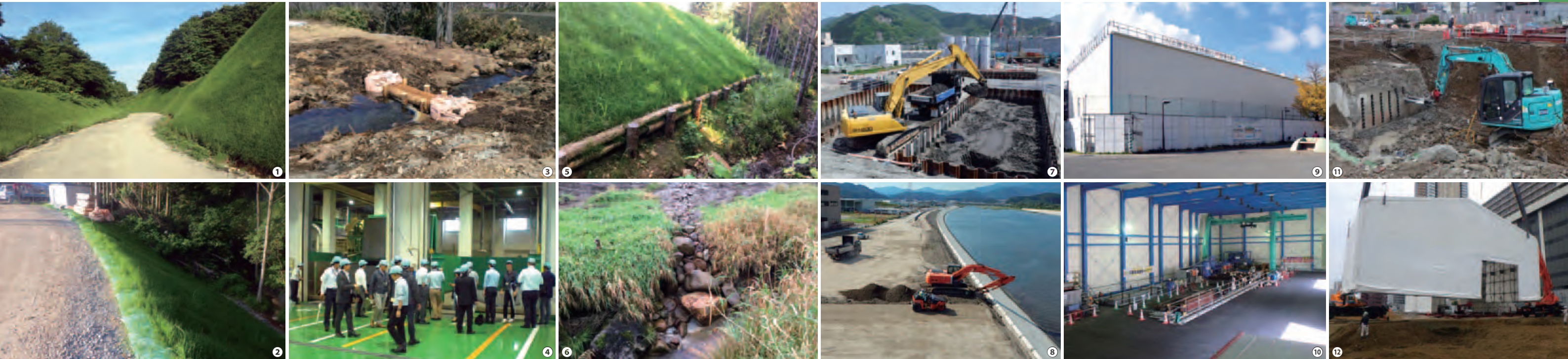
①: 法面保護・緑化 ②: 法肩植生土のう ③: 沢に設置されたバイオログフィルター ④: 産業廃棄物処理施設見学会 ⑤: 伐採材を再利用した土砂流出防止柵 ⑥: 転石を再利用した排水暗渠 ⑦: 排泥の収集運搬 ⑧: 護岸の盛土材として再利用 ⑨⑩: 防音ハウス外観と内部 ⑪: コア抜きアタッチメントを装着したバックホウでの解体作業 ⑫: 揮散防止対策に大型テントを設置
