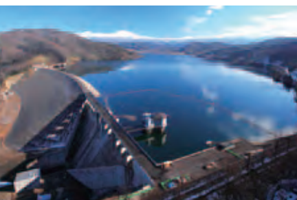
新忠別水力発電所 (北海道)
