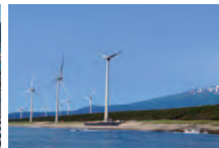
西遊佐風力発電所 (山口県)
