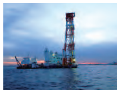
新海面処分場Dブロック東側護岸地盤改良(東京都)
