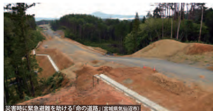
災害時に緊急避難を助ける「命の道路」 (宮城県気仙沼市)
