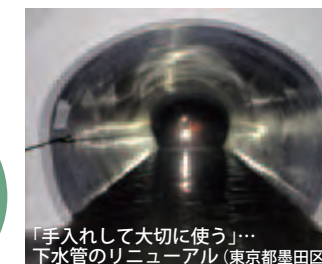
RPC工法による下水管の更生 (東京都豊島区)
