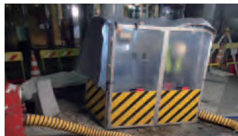
騒音・粉じんの影響を軽減する地下工事
