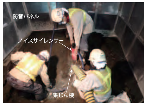
防音パネル内での既存コンクリート壁撤去作業
