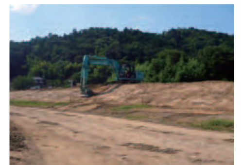
築堤盛土施工の様子
