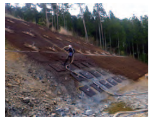
法面への吹き付け作業(宮城県気仙沼市)
