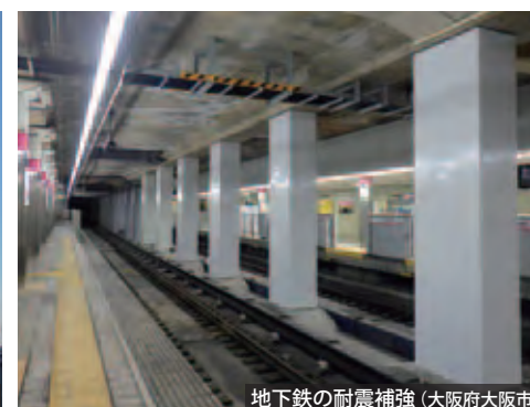
地下鉄の耐震補強 (大阪府大阪市)
