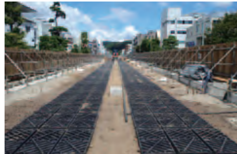
『段葛』路盤下に樹脂製貯留槽を配置
