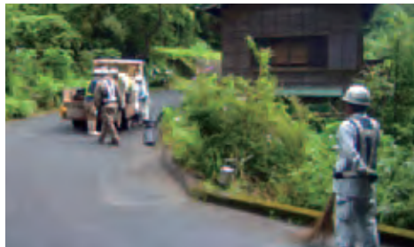
土嚢設置作業の様子 (静岡県清水市)
