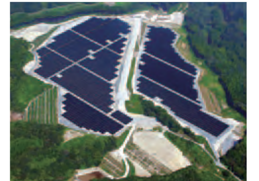
鹿児島県の太陽光発電施設
