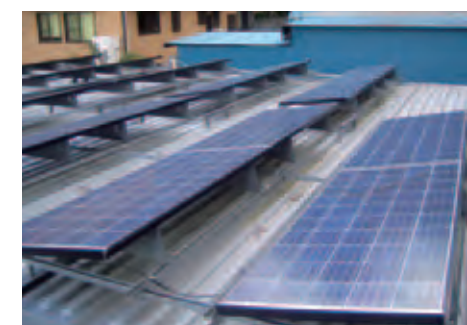
現場事務所屋根に設置された太陽光パネル
