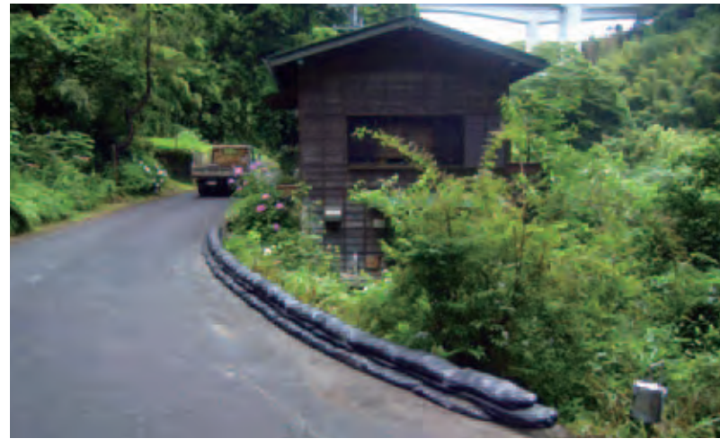
土嚢設置完了 (静岡県清水市)
