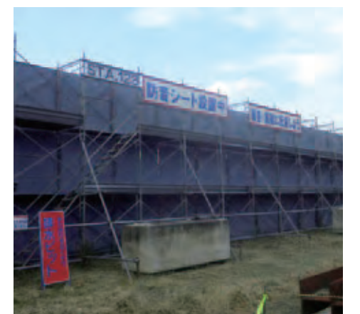
騒音・粉じんを抑制する防音シート足場
