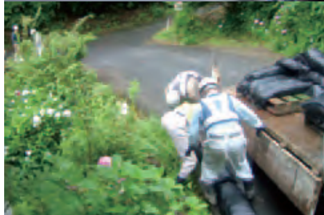
土嚢設置完了 (静岡県清水市)
