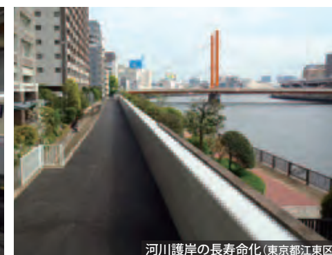
河川護岸の長寿命化 (東京都江東区)
