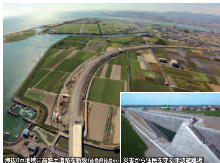
海拔0m地域に高盛土道路を新設 (徳島県徳島市)
