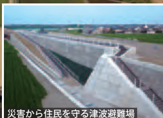
災害から住民を守る津波避難場
