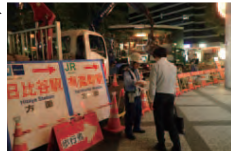
地下鉄駅利用者への配慮…案内板の設置及び誘導員の配置
