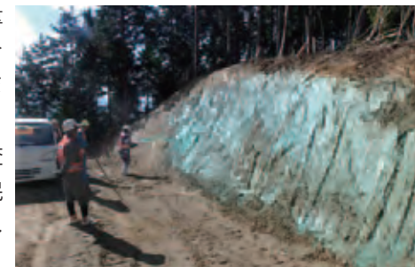
「法面浸食防止剤」を散布
