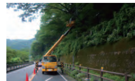
道路脇の樹木伐採・除草作業
