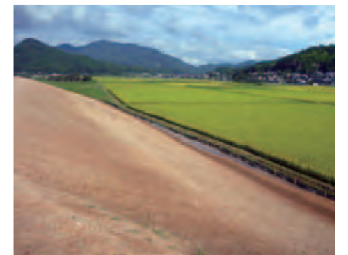
完成した築堤盛土
