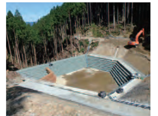
完成した仮設沈砂池(高知県長岡郡)
