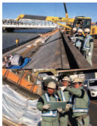
2016年度 現場研修（中川防潮堤整備工事）
