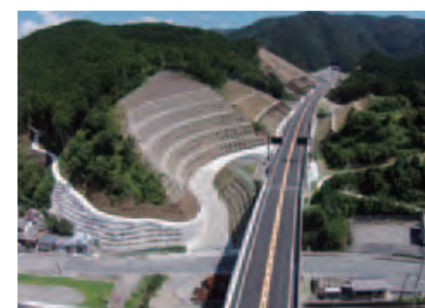
高速道路全景
