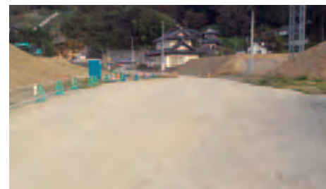
再生碎石を利用した工事用道路
