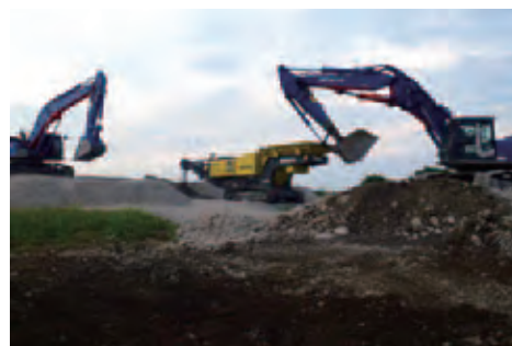
コンクリート魂の集積・破砕作業
