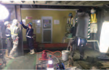
止水壁の施工状況
