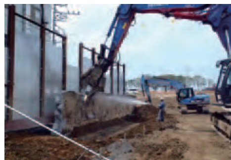
既存コンクリート擁壁撤去作業
