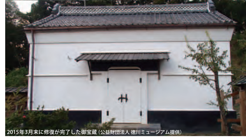
2015年3月末に修復が完了した御宝蔵(公益財団法人 徳川ミュージアム提供) 徳川家伝来の「什宝」が納められた「御宝蔵」を、できる限りオリジナルの部材を再利用して修復しました。
