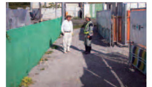
碎石舗装により整備された通路
