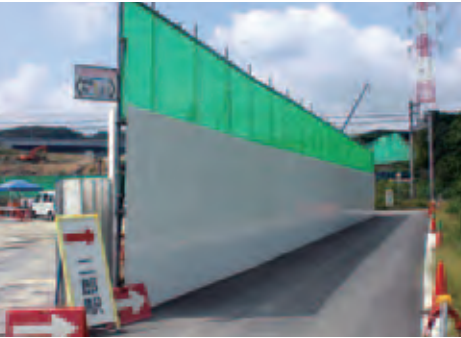
騒音・粉塵を抑制する高さ5mの仮囲い
