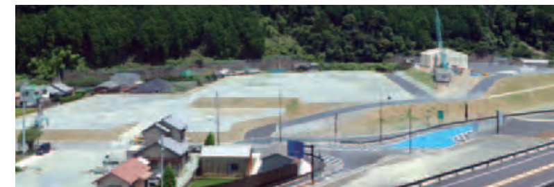
「すさみ防災基地」敷地全景
