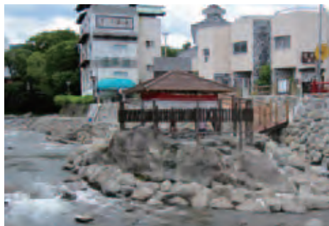
伊豆・修善寺川の河川整備に伴い、修善寺温泉の象徴的存在である『独鈷の湯』を、ジャッキを利用して1時間に1mのペースで19m下流側に移設・保存しました。
