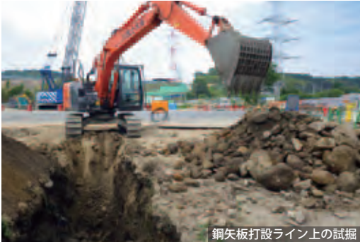
鋼矢板打設ライン上の試掘
