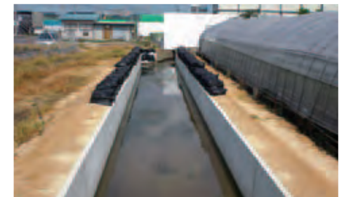
整備されたコンクリート水路
