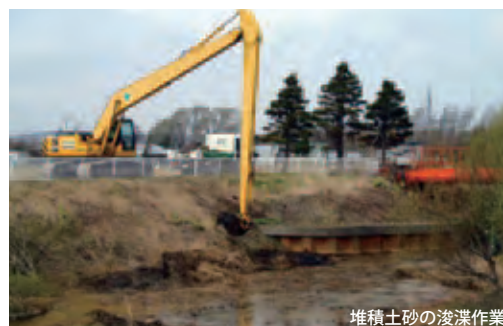
堆積土砂の浚渫作業
