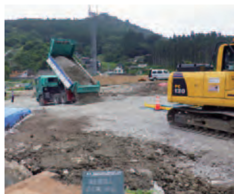
工事用道路敷き均し状況
