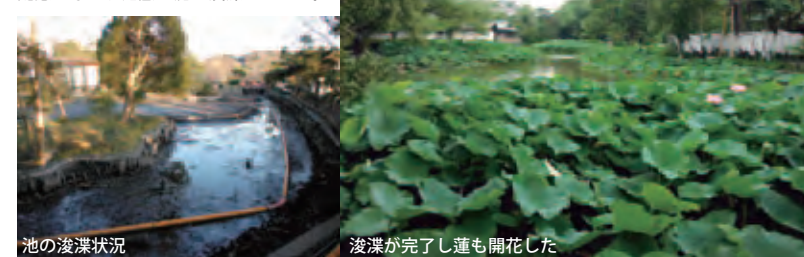
鶴岡八幡宮・源平池(鎌倉市) 池の水環境改善のために、蓮の生育に配慮しながら池底の泥を浚渫しました。
