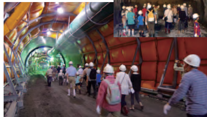
工事見学会の様子…福井県のトンネル工事
