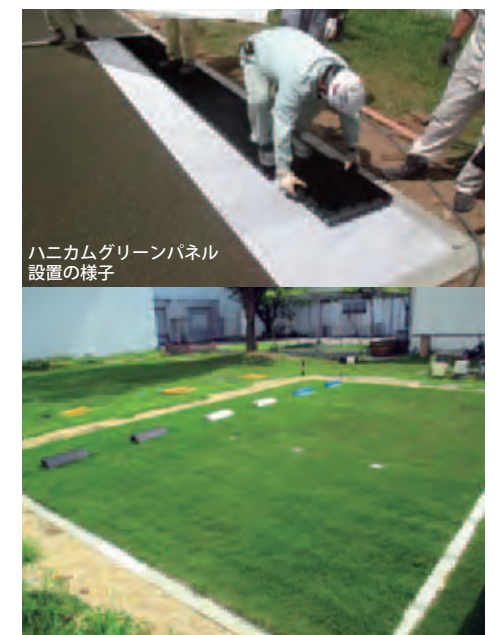
緑化駐車場の施工
