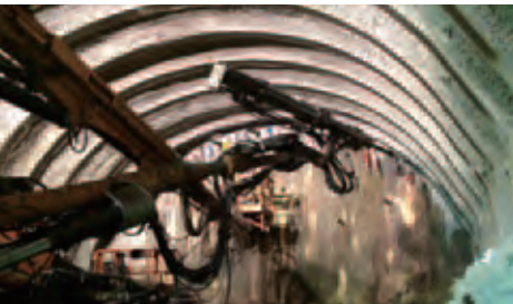
トンネル工事の施工時に発生する資材のリユースとリサイクル
