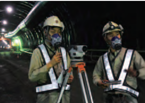
現場研修で先輩から指導を受ける(冠山第2トンネル)
