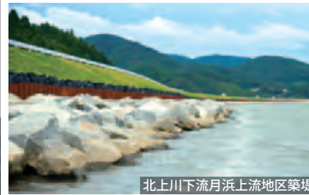
北上川下流月浜上流地区築堤
