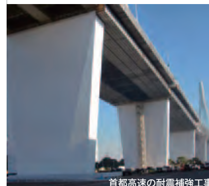
首都高速の耐震補強工事
