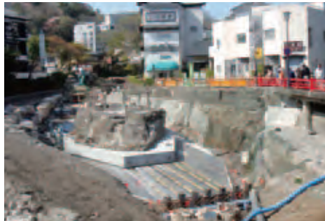
伊豆・修善寺川の河川整備に伴い、修善寺温泉の象徴的存在である『独鈷の湯』を、ジャッキを利用して1時間に1mのペースで19m下流側に移設・保存しました。
