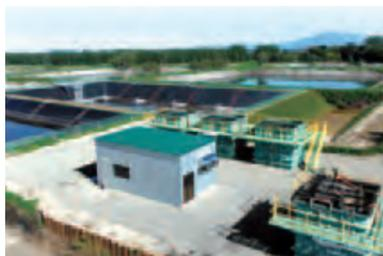
超深層曝気法によるでん粉工場廃液の臭気対策
