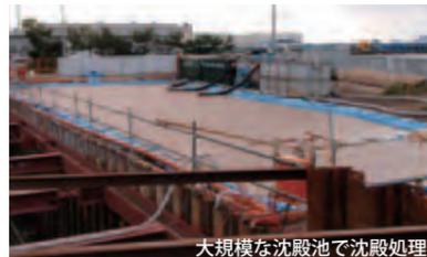
大規模な沈殿池で沈殿処理
