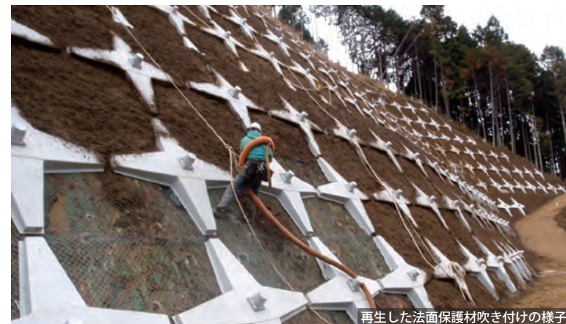
再生した法面保護材吹き付けの様子
