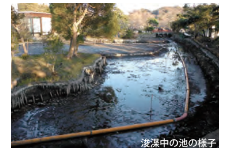
浚渫中の池の様子
