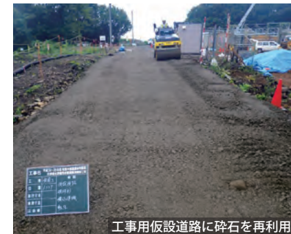
工事用仮設道路に碎石を再利用
