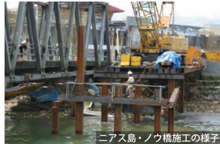
ニアス島・ノウ橋施工の様子
