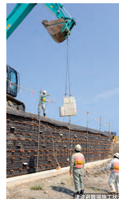
津波避難場施工状況
