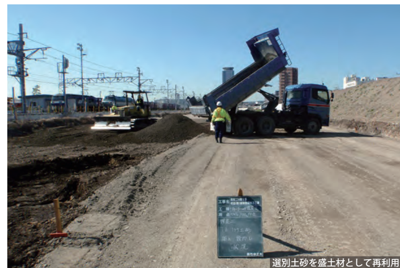
選別土砂を盛土材として再利用
