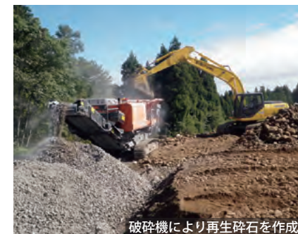
破碎機により再生碎石を作成
