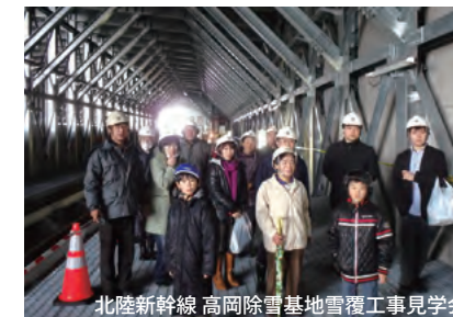
北陸新幹線 高岡除雪基地雪覆工事見学会
