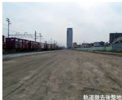
軌道撤去後整地
