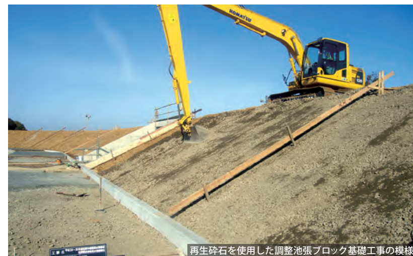
再生碎石を使用した調整池張ブロック基礎工事の模様
