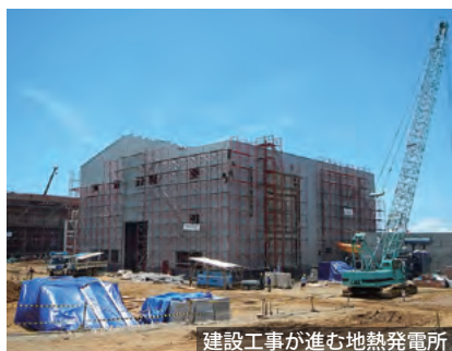
建設工事が進む地熱発電所
