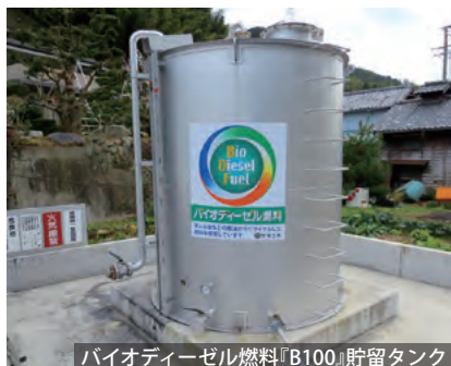
バイオディーゼル燃料『B100』貯留タンク
