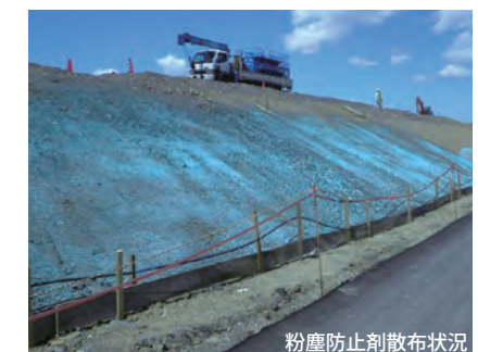
粉塵防止剤散布状況
