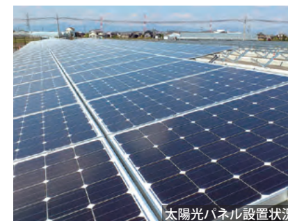
太陽光パネル設置状況
