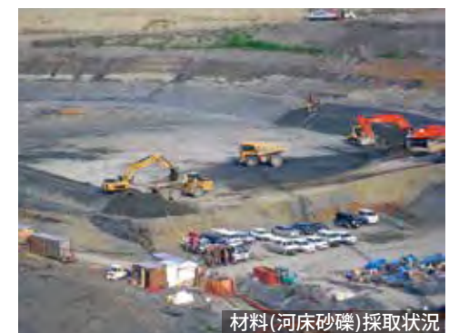
材料(河床砂礫)採取状況
