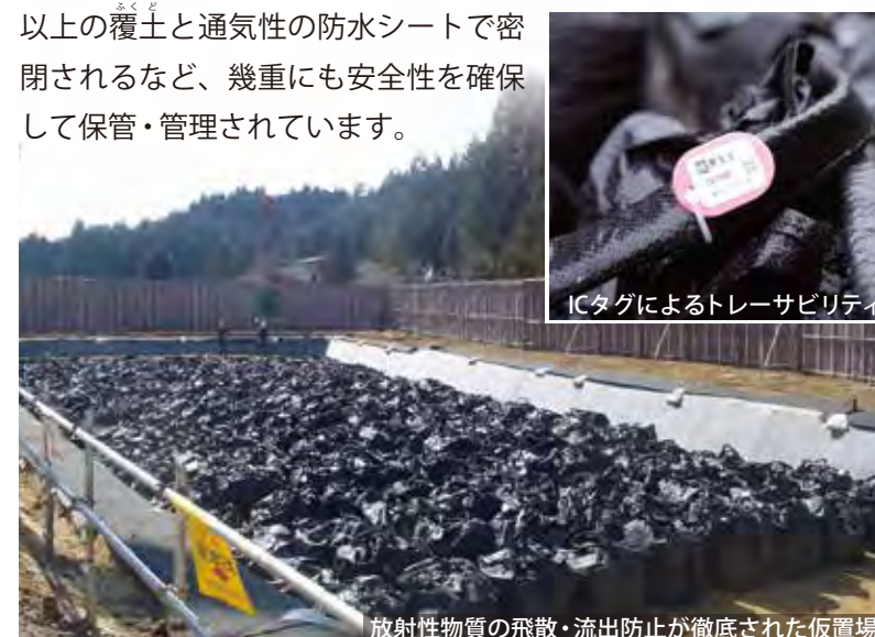
放射性物質の飛散・流出防止が徹底された仮置場
