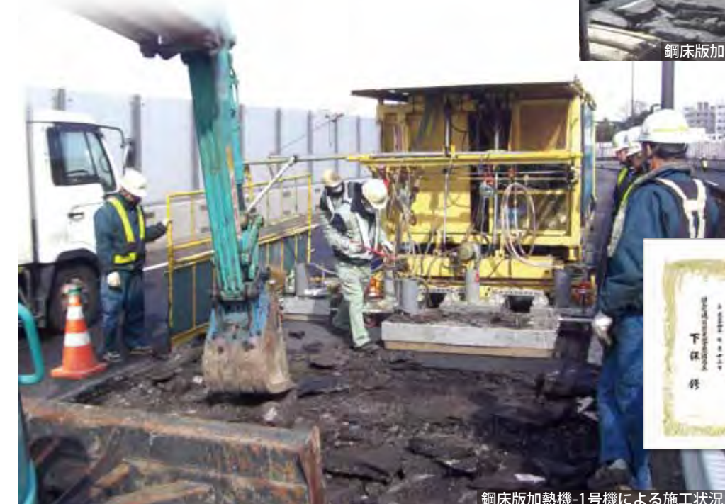
鋼床版加熱機-1号機による施工状況
