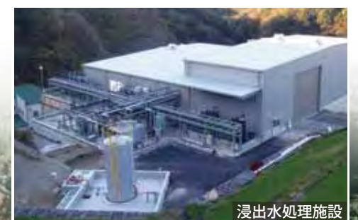
浸出水処理施設
