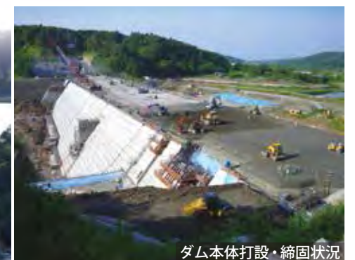
ダム本体打設・締固状況
