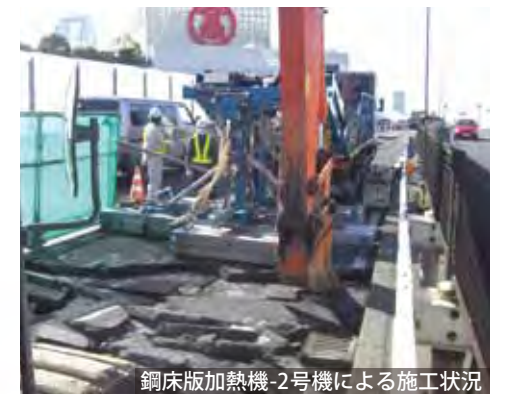
鋼床版加熱機-2号機による施工状況
