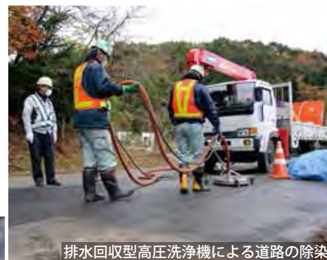
排水回収型高压洗浄機による道路の除染
