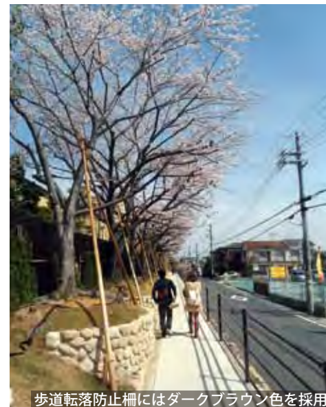
歩道転落防止柵にはダークブラウン色を採用
