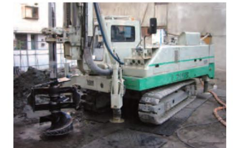
小型単軸地盤改良機による狭小地施工
