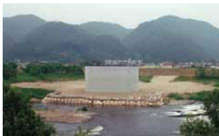
フライアッシュコンクリートによる橋脚の施工
