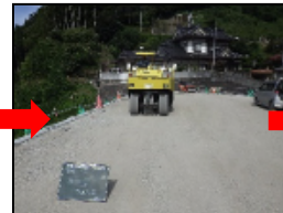
路盤転圧状況
