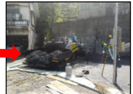
アスファルト舗装状況
