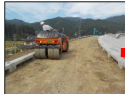
路床転圧状況
