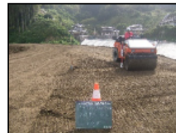
盛土転圧状況
