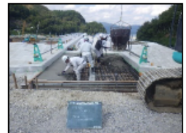
コンクリート打設
