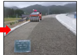
路盤転圧状況
