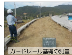
ガードレール基礎の測量
