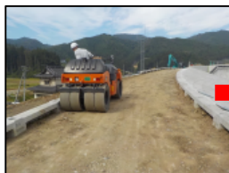
路床転圧状況
