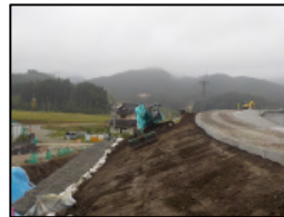
法面整形状況
