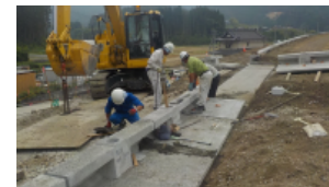
右岸No.3+25川ウラ付近
