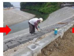
張りブロック据付
