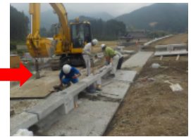
ガードレール基礎据付
