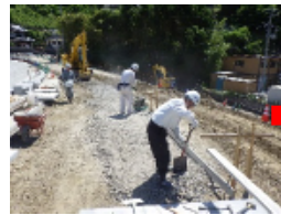
基礎砕石敷き均し転圧
