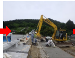
均しコンクリート打設
