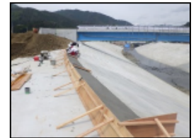
張りブロック基礎コン打設
