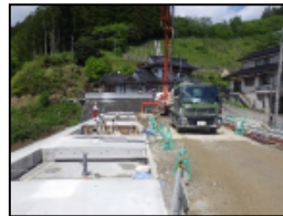
コンクリート打設状況
