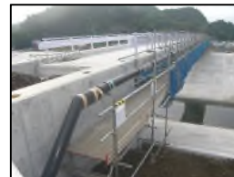
添架管敷設完了
