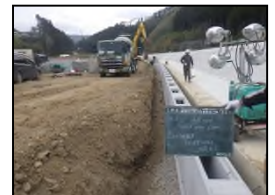
勾配コンクリート打設
