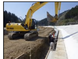
堤脚水路据付
