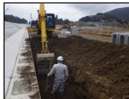
掘削・床付け状況
