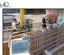
コンクリート打設
