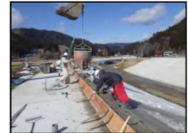
コンクリート打設
