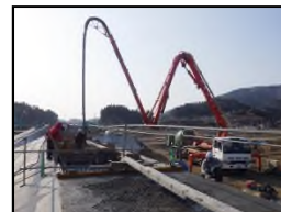
コンクリート打設
