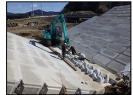
減勢ブロック据付状況
