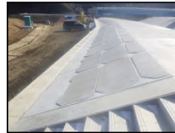
川裏ブロック間詰完了
