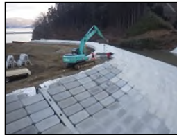
被覆ブロック設置
