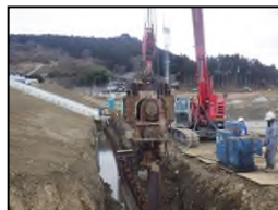
基礎矢板打設状況
