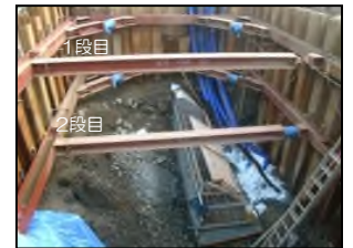
C基礎 山留設置状況 （必要資格：土留め支保工）
