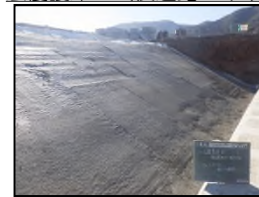
均しコンクリート打設完了
