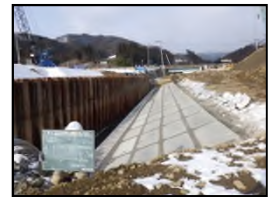
被覆ブロック（河床部）完了
