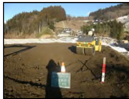
敷き均し転圧
