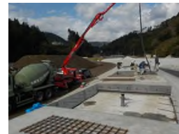
コンクリート打設
