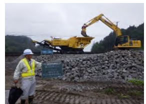
コンクリート廃材を砕石に再利用
