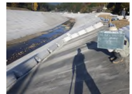
均しコンクリート打設完了
