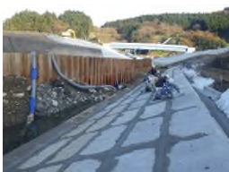
間詰めコンクリート打設
