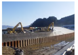
既設護岸撤去
