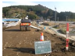
敷き均し転圧
