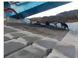
被覆コンクリート打設
