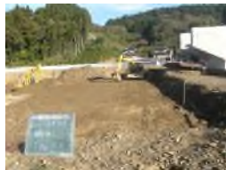
敷き均し転圧
