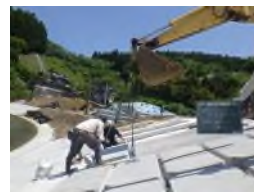
被覆ブロック据付
