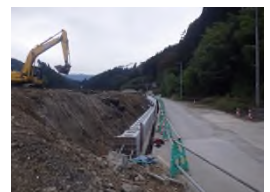
基礎ブロック据付
