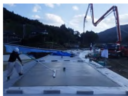
コンクリート打設
