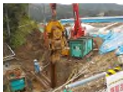
基礎矢板打設
