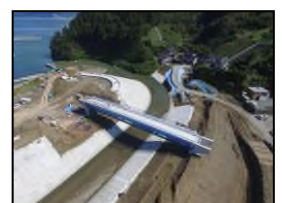
港橋完成（No.4付近）
