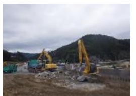
既設護岸撤去
