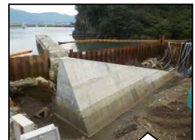
重力式擁壁 (左岸No.0+30)
