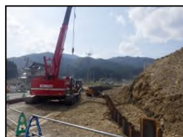
基礎矢板打設
