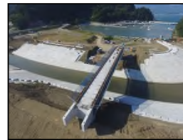
打設完了全景
