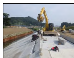
法肩70kg掘付状況
