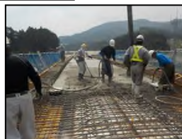
床版コンクリート打設
