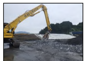
旧ローソン擁壁撤去
