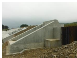
樋門④完成
