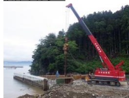
鋼矢板打設状況
