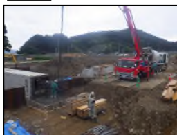
コンクリート打設状況
