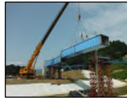
橋桁設置状況
