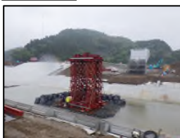
バント設置完了
