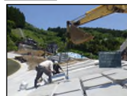
アロックス据付状況
