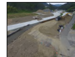
左岸上流部 盛土状況
