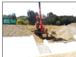
遮水矢板打設状況
