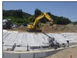
ブロック設置状況（上流部）
