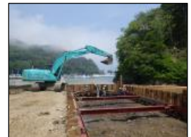
山留設置状況
