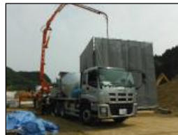
ウィング部コンクリート打設（A2） 樋管工④
