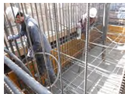
縦壁部コンクリート打設
