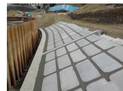
ブロック設置完了（河床部）
