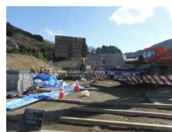
大型移動型枠 建込み
