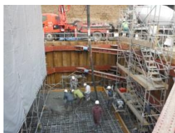
7-チツグ コンクリート打設
