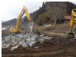
撤去状況（上流部）
