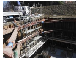
足場組立て状況
