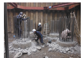
杭頭処理状況
