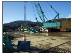
鉄筋建込み状況
