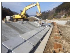
コンクリートブロック設置状況
