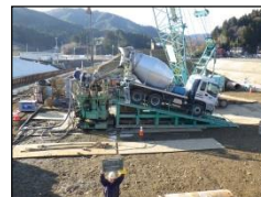
コンクリート打設状況
