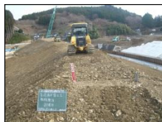
敷き均し状況
