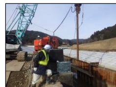
鋼矢板打設状況
