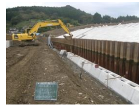
基礎ブロック据付け
