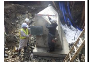
現場打ち基礎コンクリート
