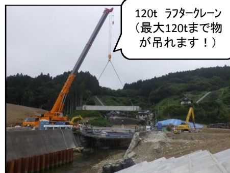
港橋 吊り上げ撤去状況
