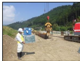
護岸基礎工（矢板）
