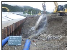
構造物撤去工
