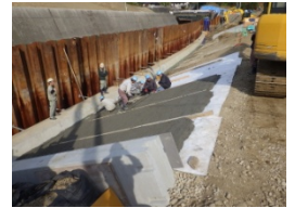
遮水シート、基礎コン打設
