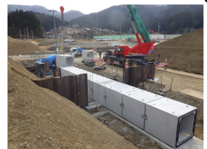
樋管（プレキャスト函体）据付け状況
